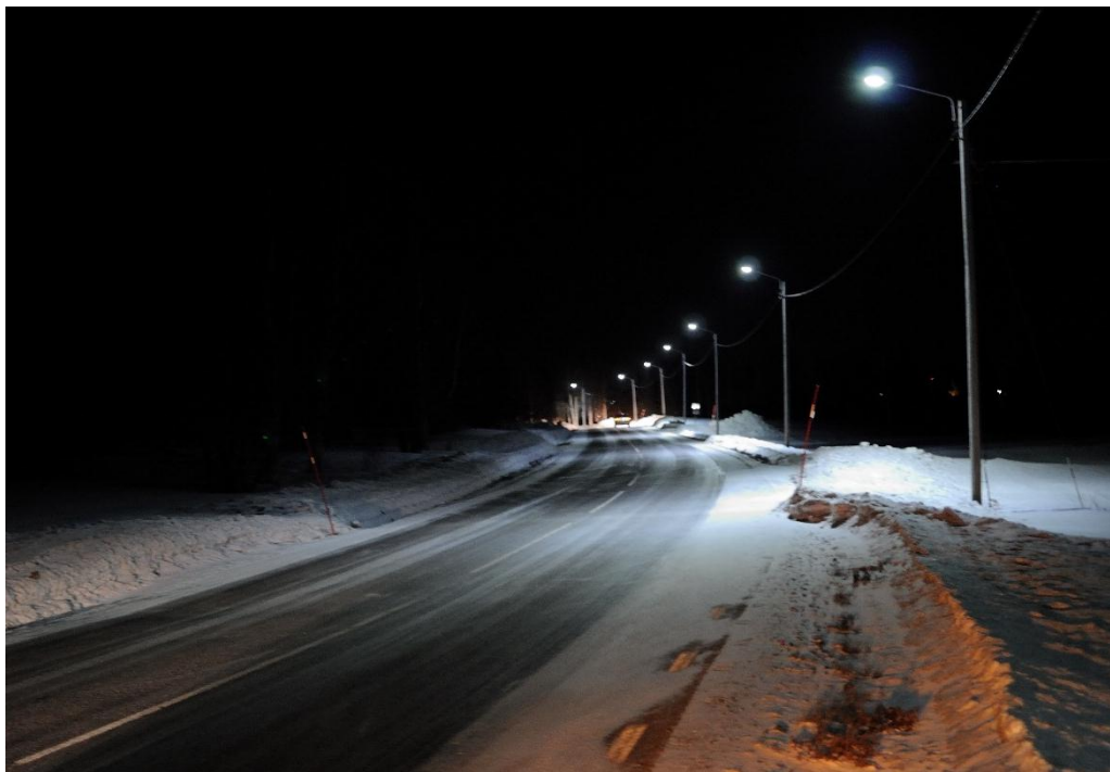
Figur 9: Vid planering av en belysningsanläggning bör man ta hänsyn till driftsaspekter, såsom snöröjning. Bild: Henrik Gidlund.
