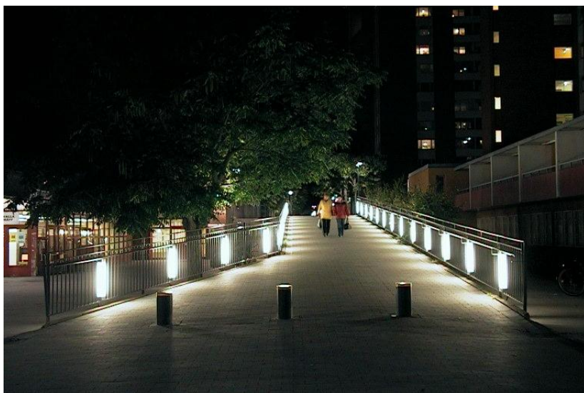
Figur 28: Belysning infälld i broräcken på GC-väg. Bild: Henrik Gidlund.
