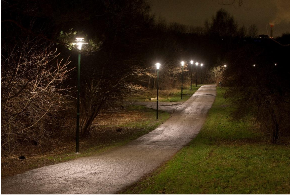
Figur 27: Belysning av GC-vägar ska av trygghetsskäl även omfatta området intill vägen. Bild: Lennart Johansson.
