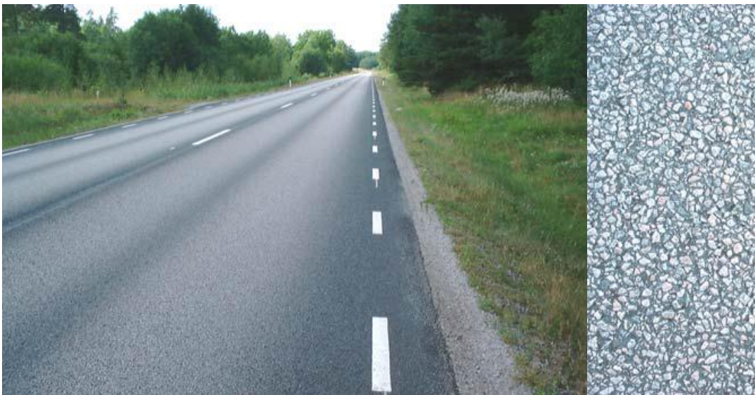
Figur 32: ABS – stenrik asfaltbetong med relativt ljus stenmaterial. Stenarnas ljushet är viktig för ljusreflexionen eftersom de förekommer rikligt på ytan. Bild: VGU 2004.
