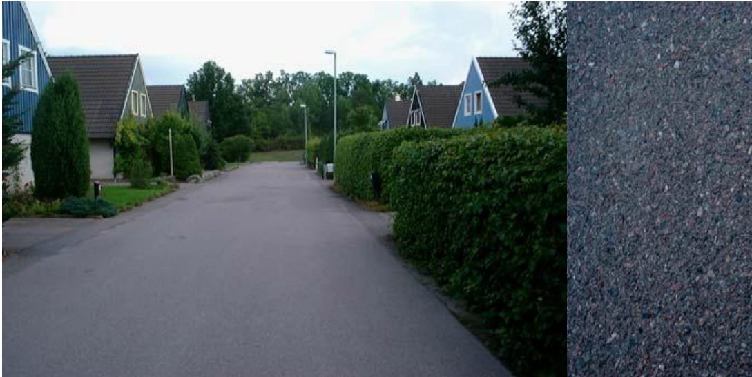
Figur 31: ABT – tät asfaltbetong. Stenmaterialets ljushet är av mindre vikt eftersom stenar på ytan endast förekommer i mindre omfattning. Bild: VGU 2004.
