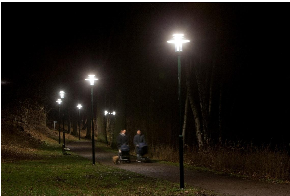
Figur 8: Förekomst av träd är av betydelse vid valet av stolphöjd och stolpplacering. Bild: Lennart Johansson.
